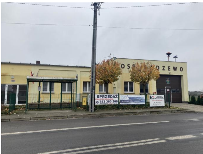
Budynek Ochotniczej Straży Pożarnej przy ul. Św. Mikołaja
