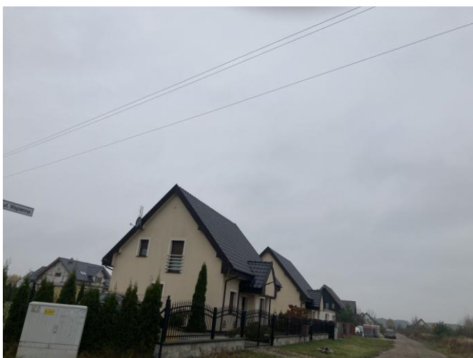
Nowa zabudowa mieszkaniowa przy ul. Wapiennej
