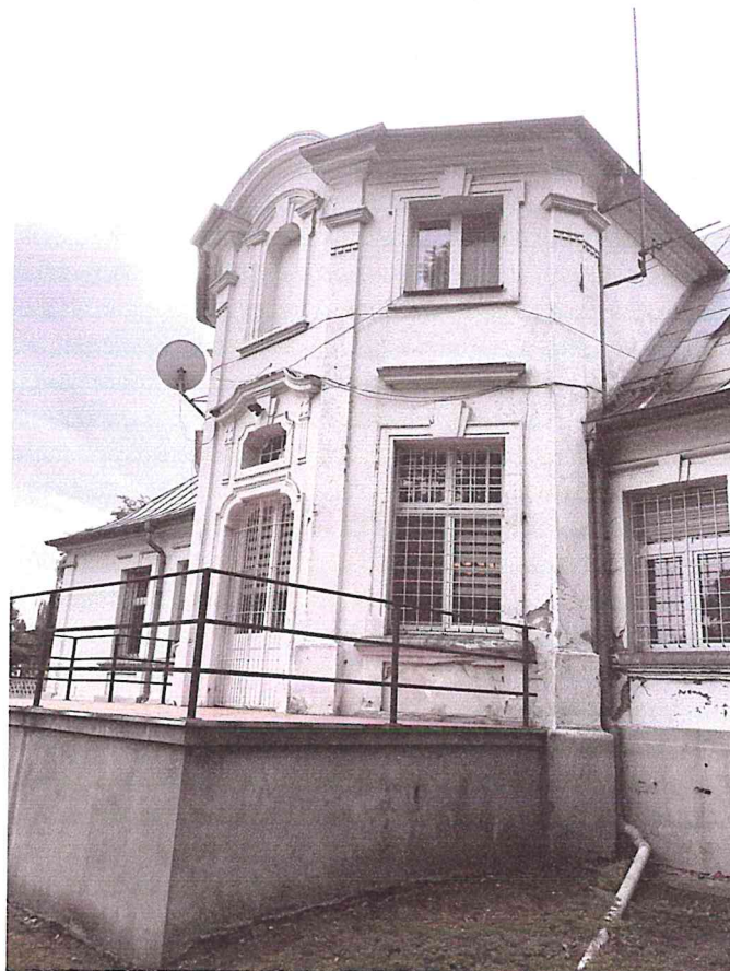
Fot. 6. Elewacja ogrodowa.
