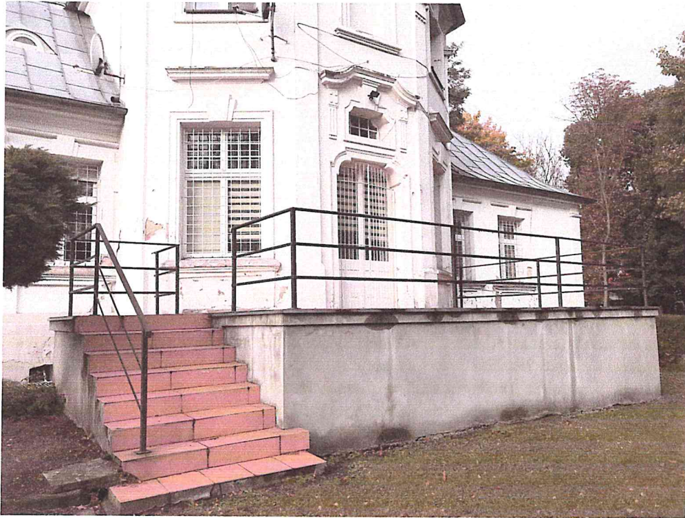
Fot. 5. Elewacja wschodnia - ogrodowa. Taras.
