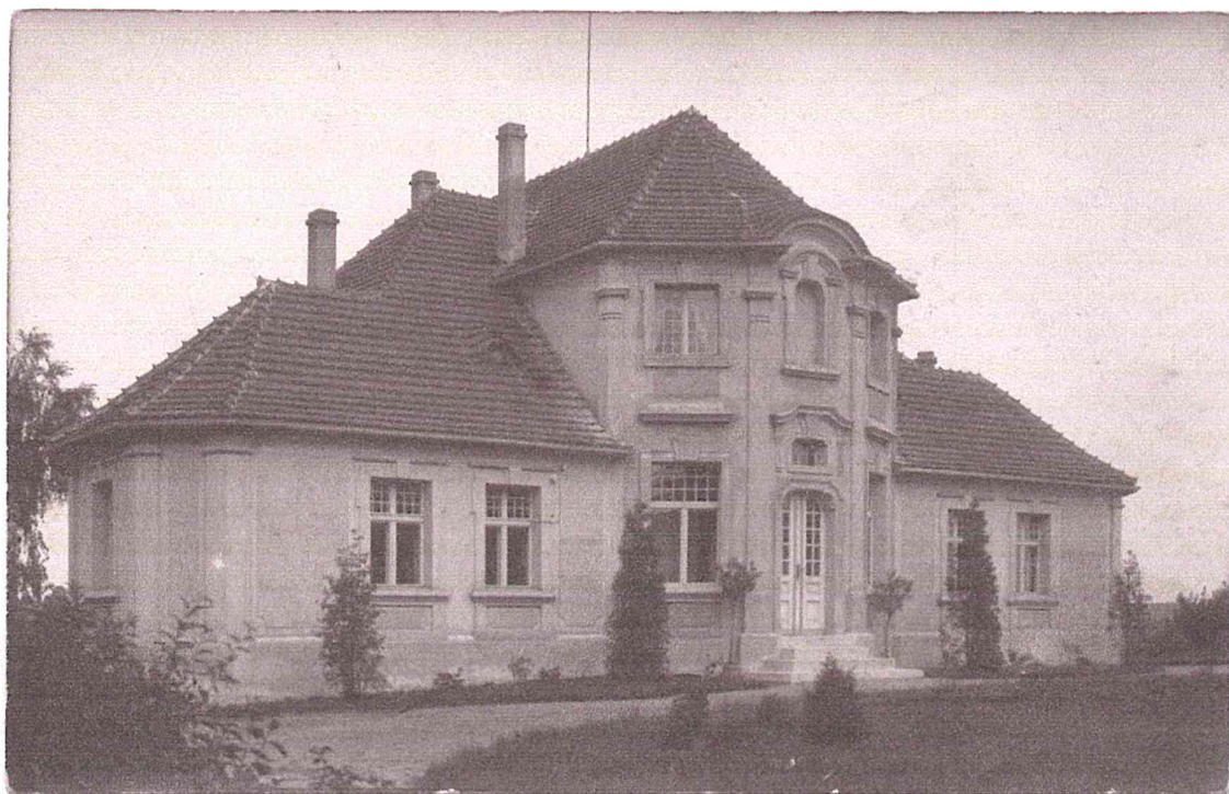
Fot. 14. Historyczne zdjęcie z lat 30-tych XXw. Pokrycie dachu - dachówka karpiówka. Wyraźne pola ozdobne tynku gruboziarnistego. Układ okien - ze szprosami.
