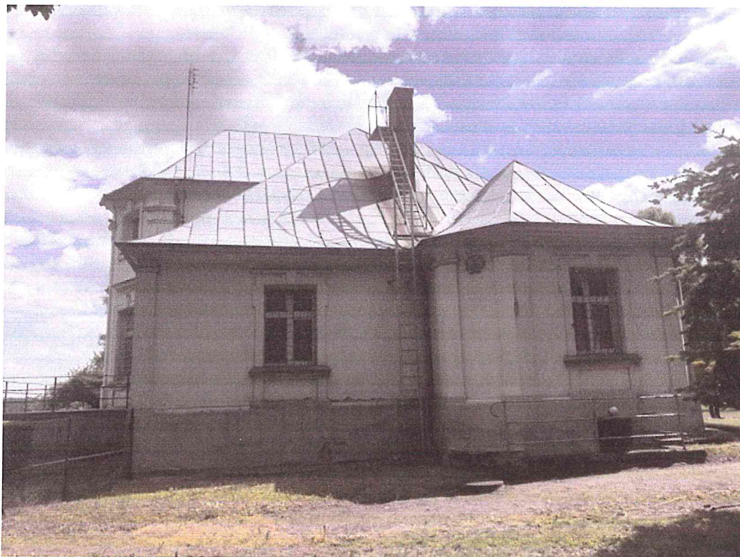
Fot. 8. Elewacja północna. Drabina przy kominie do demontażu.
