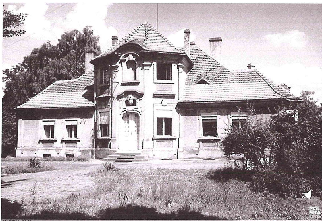
Fot. 14. Historyczne zdjęcie z lat 30-tych XXw. Pokrycie dachu - dachówka karpiówka. Wyraźne pola ozdobne tynku gruboziarnistego. Układ okien - ze szprosami.
