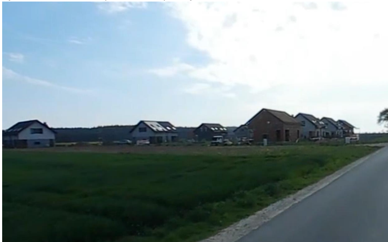
Ryc. 9 Widok na zabudowę mieszkaniową w miejscowości Czołowo
