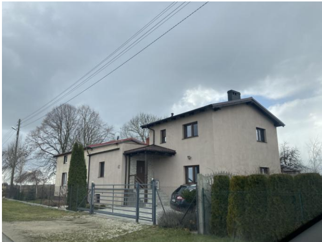
Budynki mieszkalne jednorodzinne
