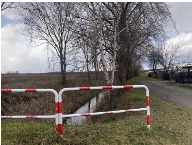
Rów melioracyjny przy południowej granicy obszaru planu
