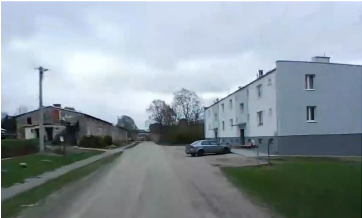
Ryc. 10 Widok na zabudowę mieszkaniową w miejscowości Żerniki
