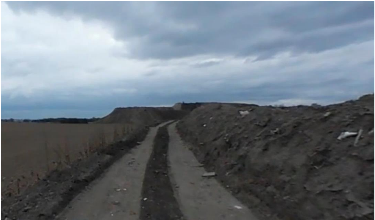
Ryc. 14 Widok na budowlę ziemną zlokalizowaną w sąsiedztwie lotniska Żerniki oraz rzeki Kopel
