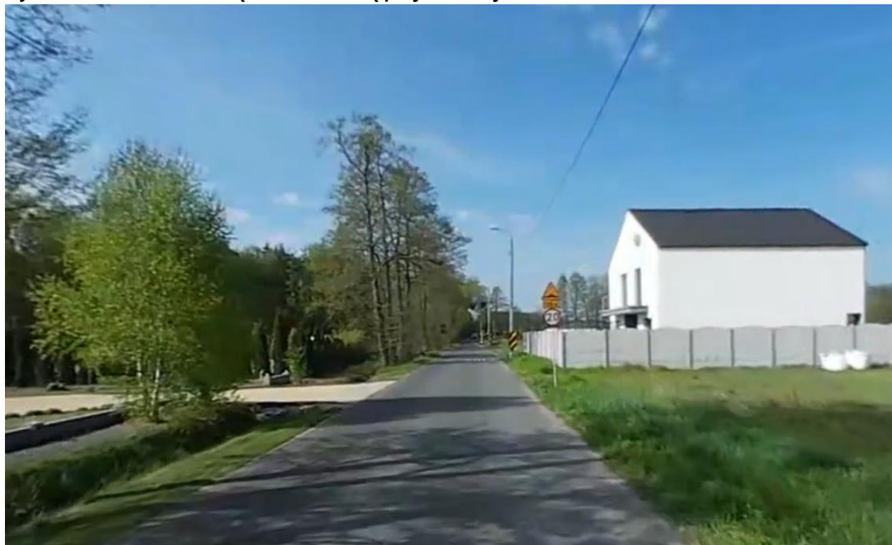
Ryc. 5 Widok na zabudowę zlokalizowaną przy ul. Huby
