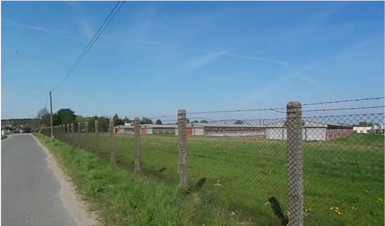
Ryc. 10 Widok na zabudowę hodowlaną Stacji Zasobów Genetycznych Drobia Wodnego w Dworzyskach
