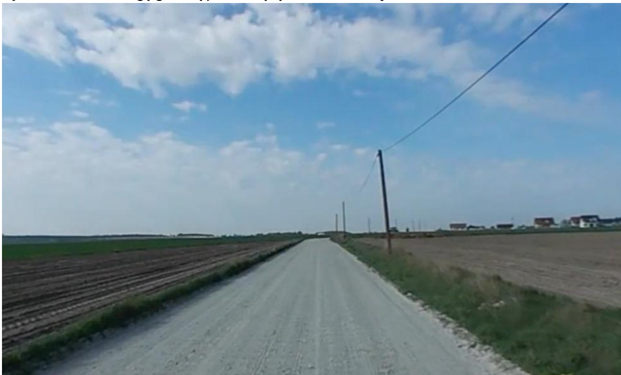
Ryc. 15 Widok na drogę gminną prowadzącą w kierunku miejscowości Konarskie
