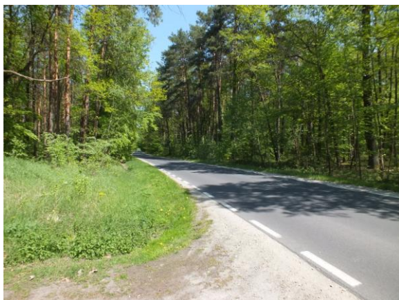
11. Widok na drogę powiatową - ulicę Kórnicką
