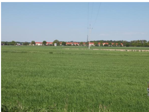
5. Widok na linię elektroenergetyczną znajdującą się na obszarze objętym planem miejscowym z ulicy Polnej
