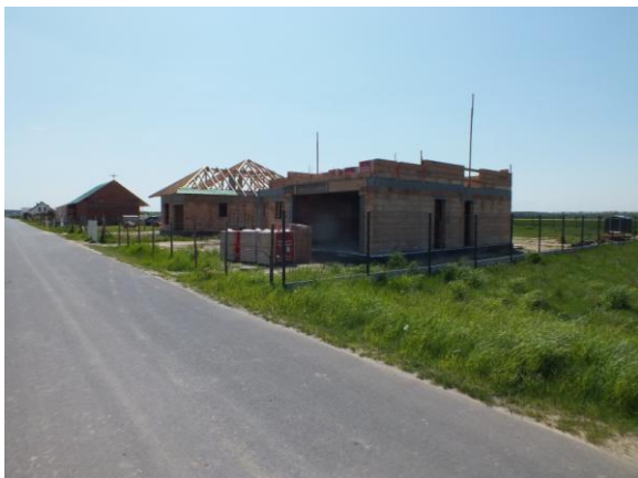
9. Widok na budynki w trakcie budowy usytuowane przy ulicy Polnej
