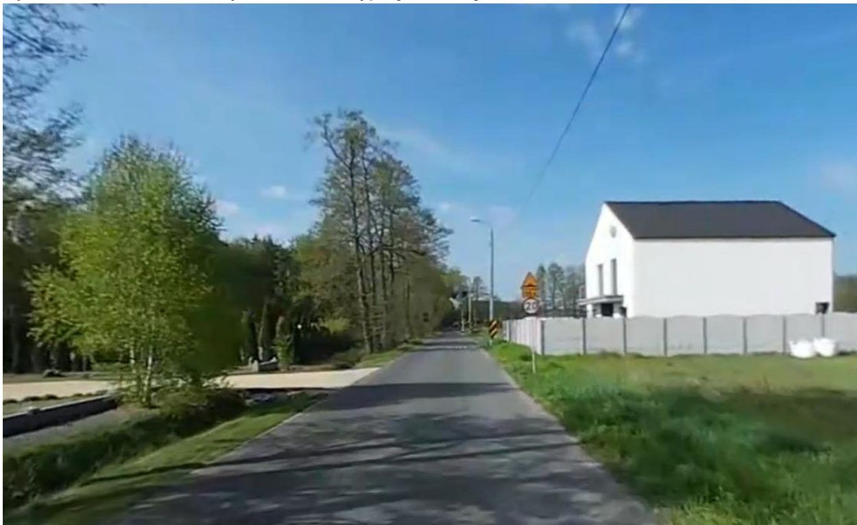
Ryc. 5 Widok na zabudowę zlokalizowaną przy ul. Huby
