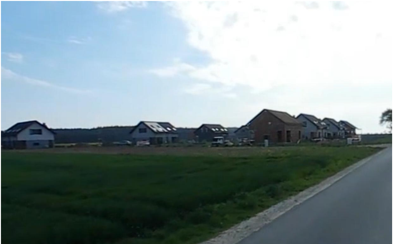
Ryc. 9 Widok na zabudowę mieszkaniową w miejscowości Czołowo
