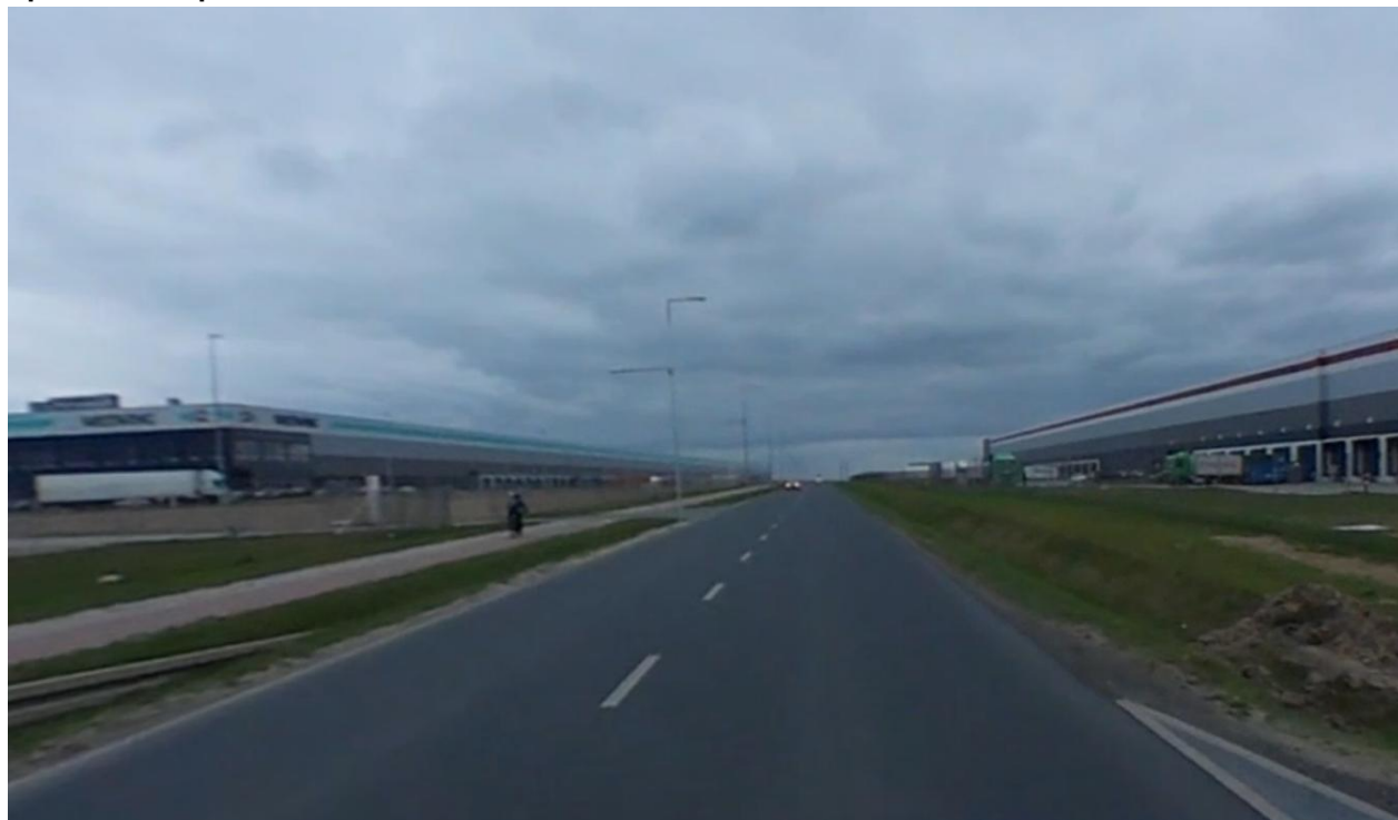
Ryc. 7 Widok z ul. Stachowskiej na hale magazynowe zlokalizowane w sąsiedztwie obszaru opracowania planu
