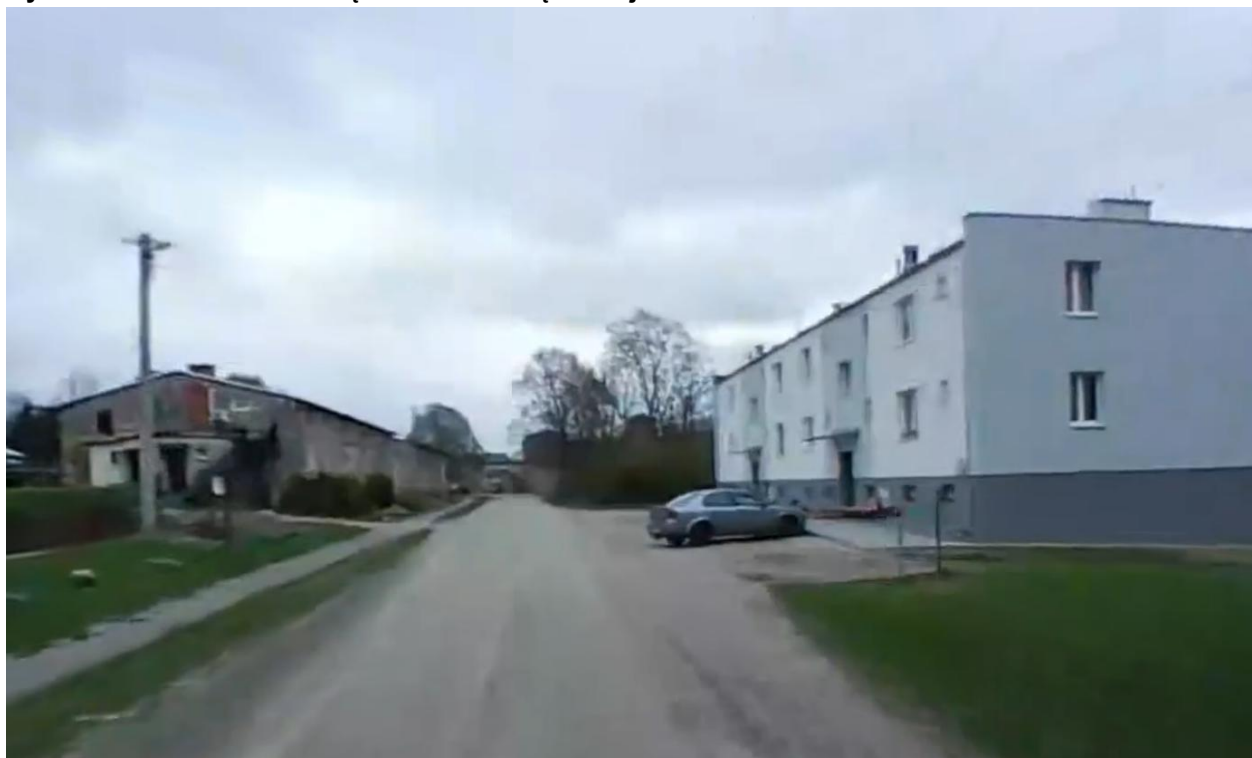
Ryc. 10 Widok na zabudowę mieszkaniową w miejscowości Żerniki
