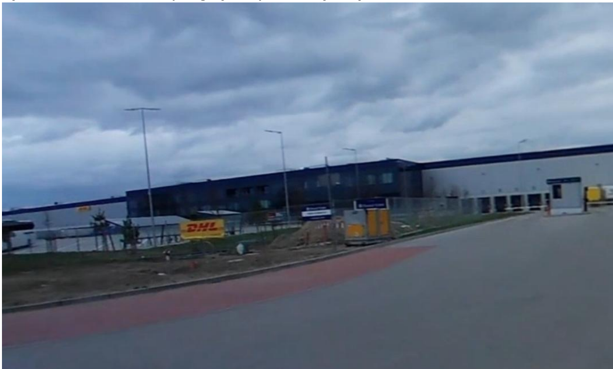
Ryc. 13 Widok na zabudowę magazynową z ul. Fabrycznej
