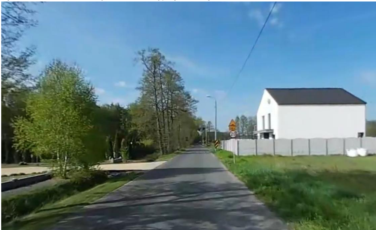
Ryc. 5 Widok na zabudowę zlokalizowaną przy ul. Huby
