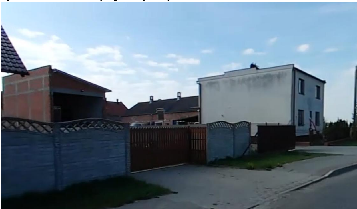
Ryc. 16 Widok na zabudowę zagrodową w miejscowości Konarskie
